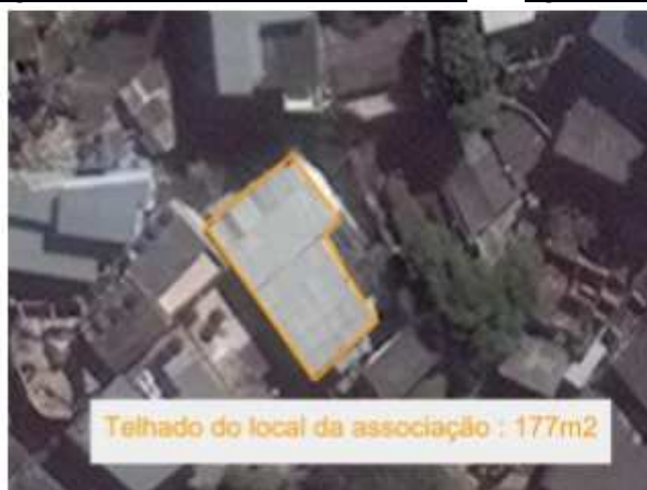
Figura 5.9: Foto aérea do telhado da AdMB
