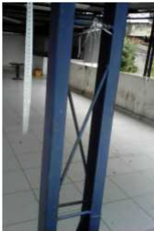
Figura 5.14: Estrutura do telhado desde dentro
